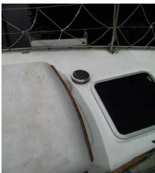
Фото 11. Грибок для вентиляции форпика.
