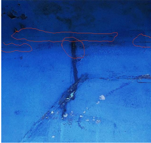
Фото 1. Области трещин обведены красным
